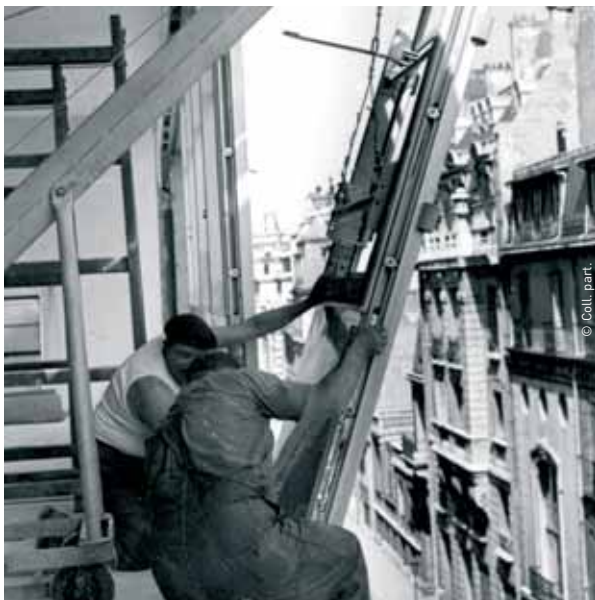
Maison du Peuple à Clichy : pose des panneaux du "mur rideau" en tôle pliée. Vers 1938.
