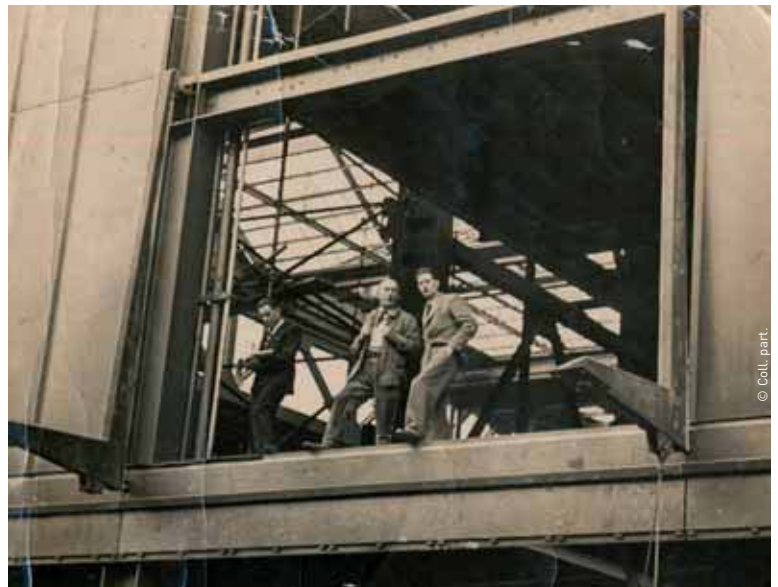
Maison du Peuple à Clichy. Jean Prouvé (à droite) et son chef de chantier "Titi" Weber, vers 1938.
