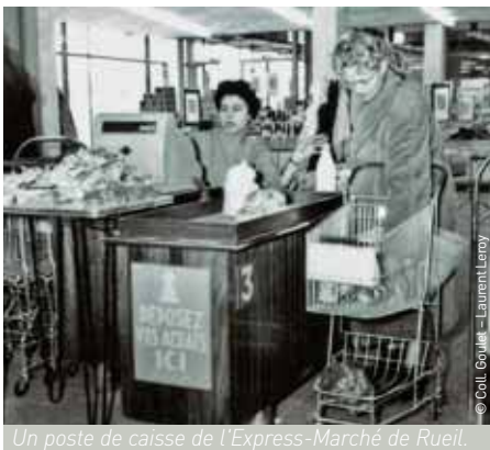
Un poste de caisse de l'Express-Marché de Rueil.
