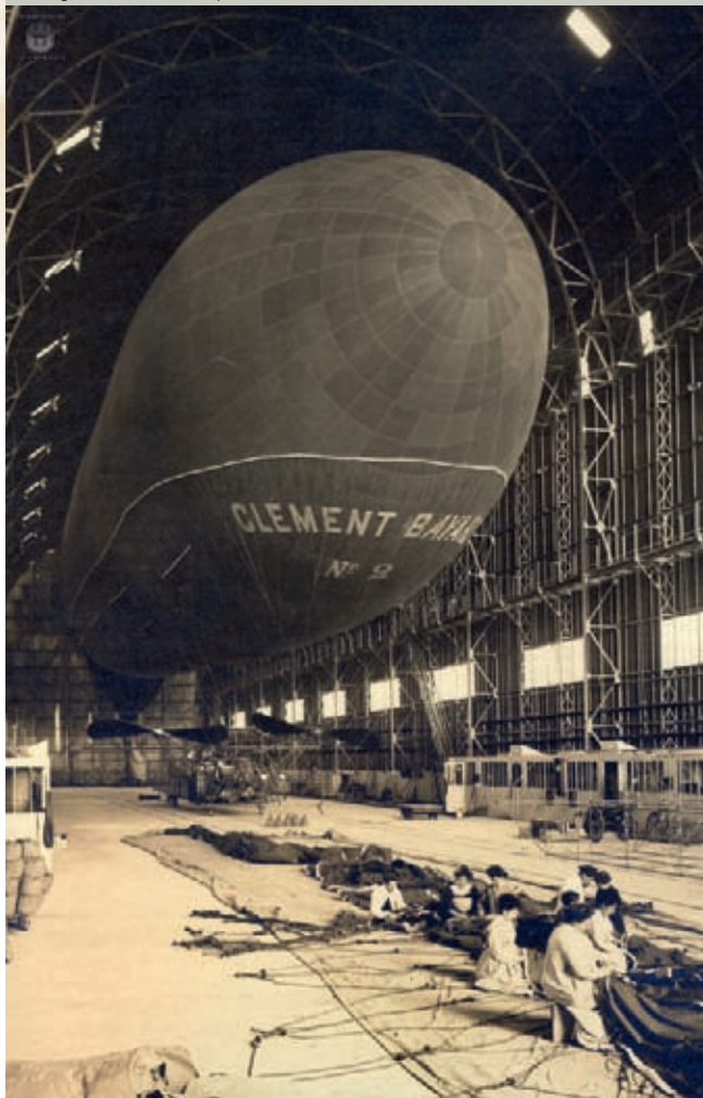
Ouvrières cousant une enveloppe de dirigeable, dans un hangar à dirigeable de l'entreprise, années 1910.
